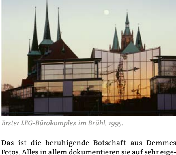
Erster LEG-Bürokomplex im Brühl, 1995.
