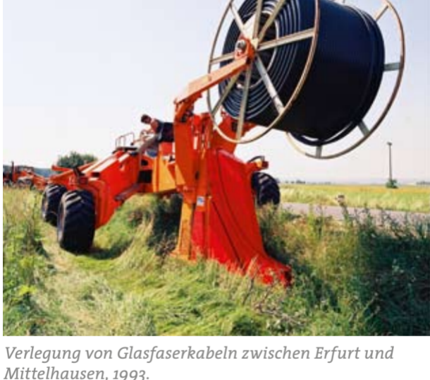
Verlegung von Glasfaserkabeln zwischen Erfurt und Mittelhausen, 1993.
