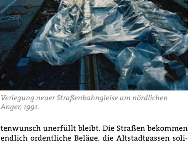
Verlegung neuer Straßenbahngleise am nördlichen Anger, 1991.
