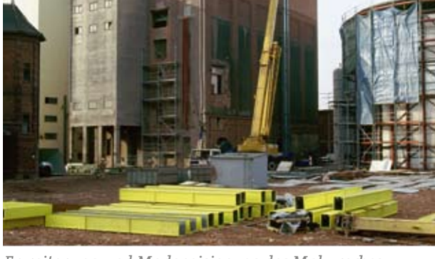
Erweiterung und Modernisierung des Malzwerkes in Erfurt-Nord, 1993.
