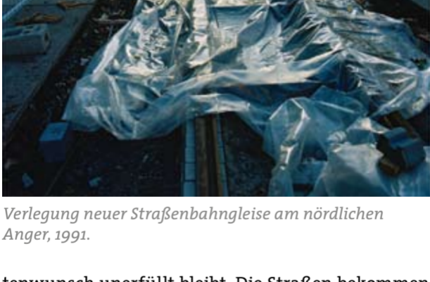
Verlegung neuer Straßenbahngleise am nördlichen Anger, 1991.
