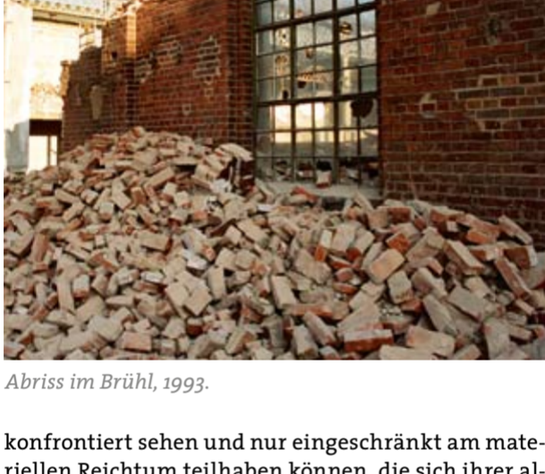
Abriss im Brühl, 1993.
