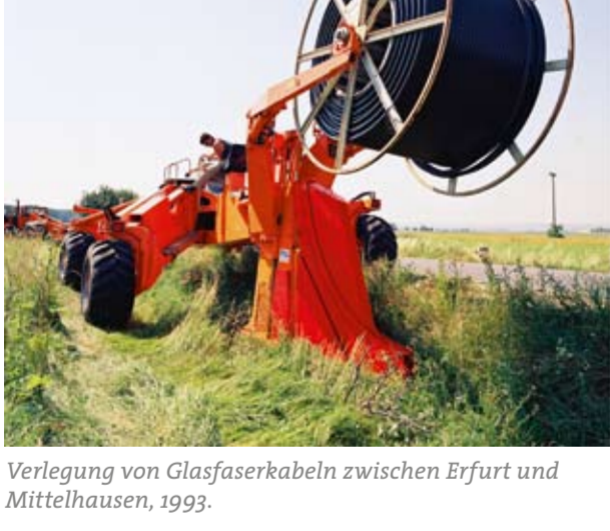
Verlegung von Glasfaserkabeln zwischen Erfurt und Mittelhausen, 1993.
